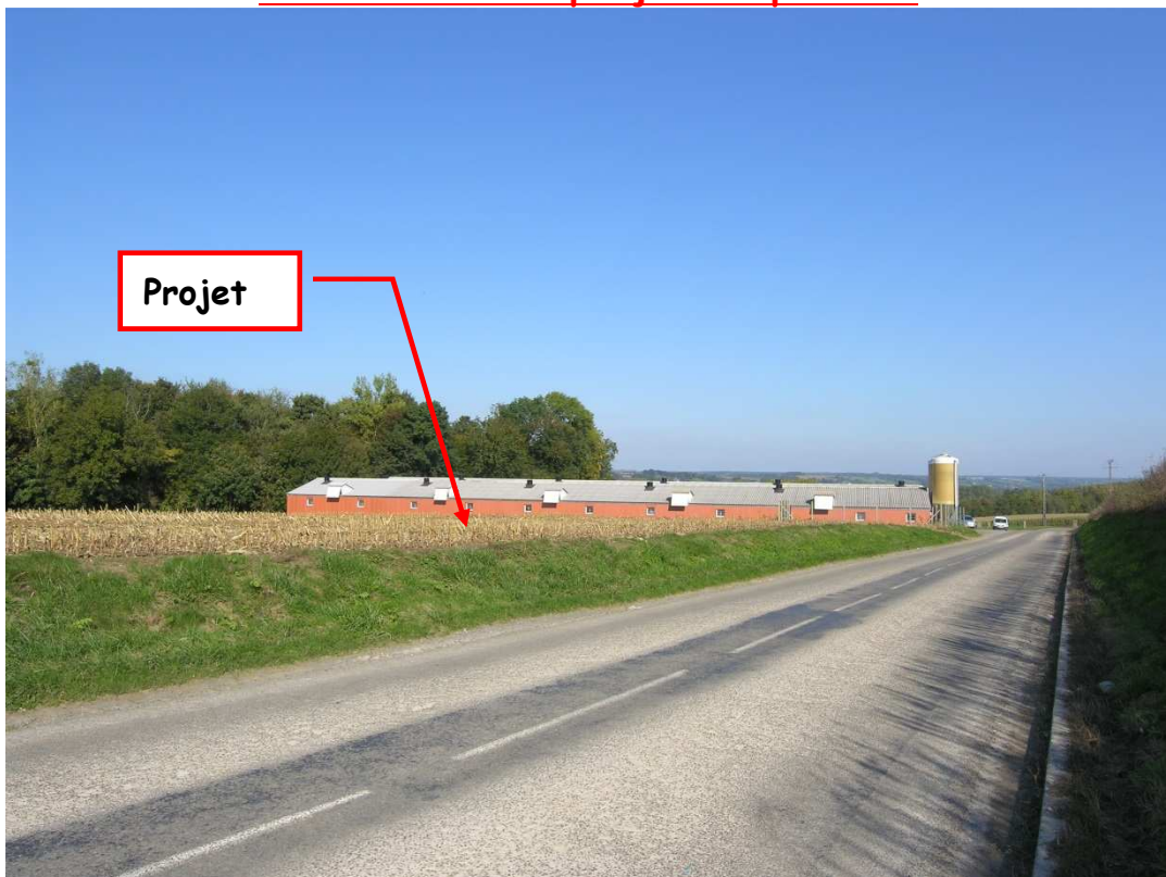
Localisation du projet sur photo 2
