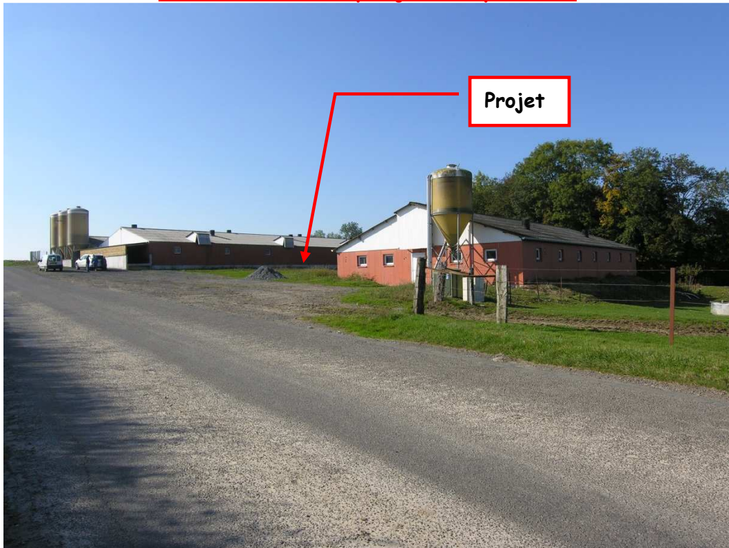
Localisation du projet sur photo 1
